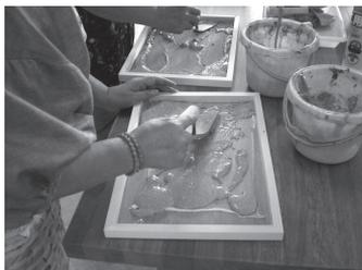
川砂を洗い土やゴミなどを取り除き、砂3ポンド1の割合で混ぜ、B4パネルの裏側にコテで圧着しながら塗る（寒冷紗を前もって貼っておくと食いつき力が増す）
